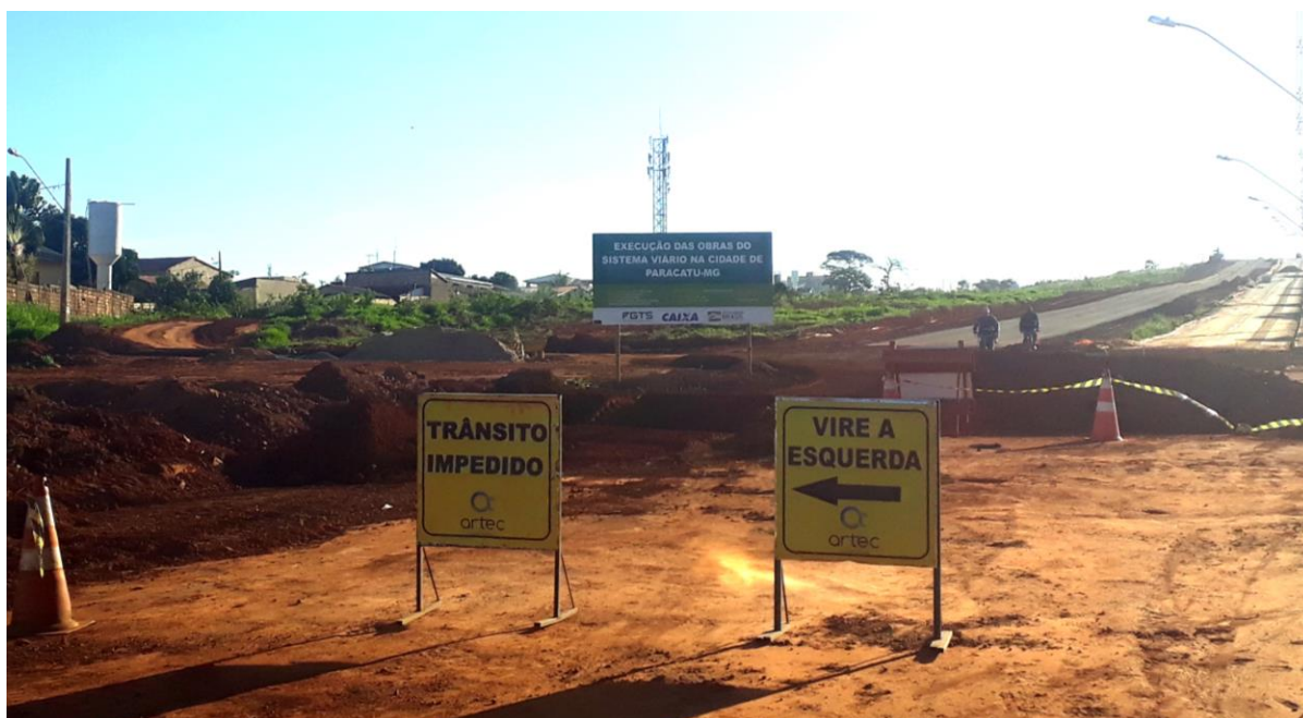
Figura 14 – Duplicação da Avenida Ladeira dos Farias
