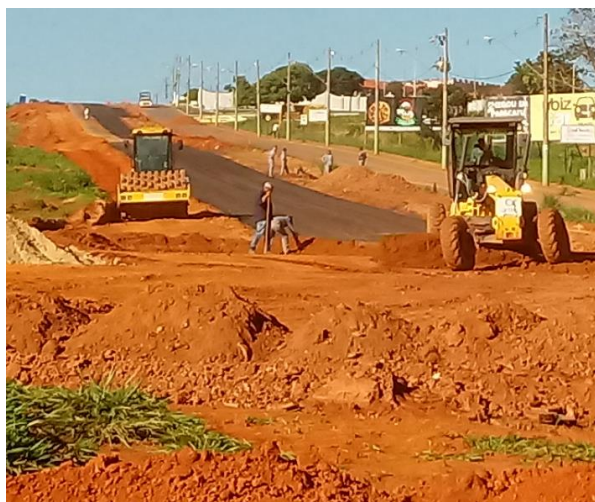
Figura 15 – Máquinas trabalhando na pavimentação da Avenida Ladeira dos Farias
